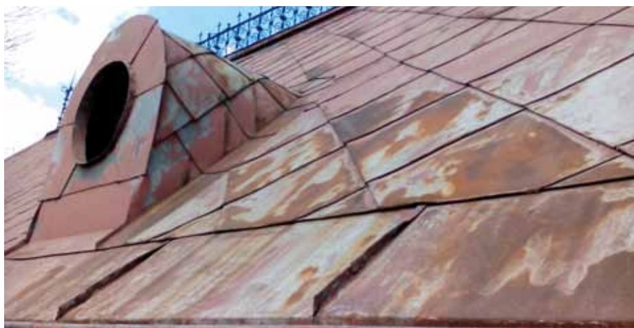
▲ Tak wyglądała blacha ocynkowana po 25 latach po ułożeniu
