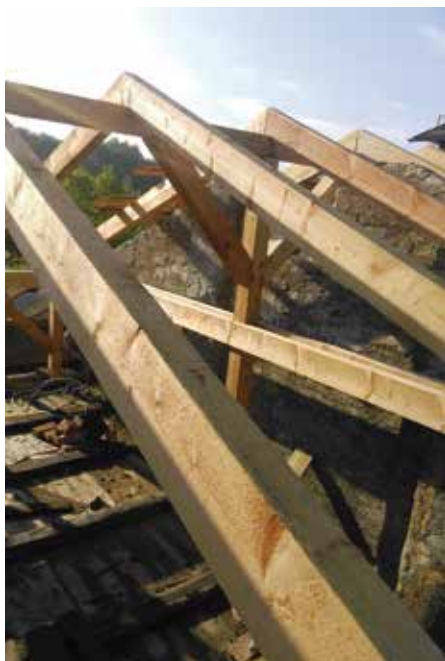
▲ Konstrukcja dwóch dachów musiała zostać całkowicie wymieniona Fot. Arkadiusz Nita
