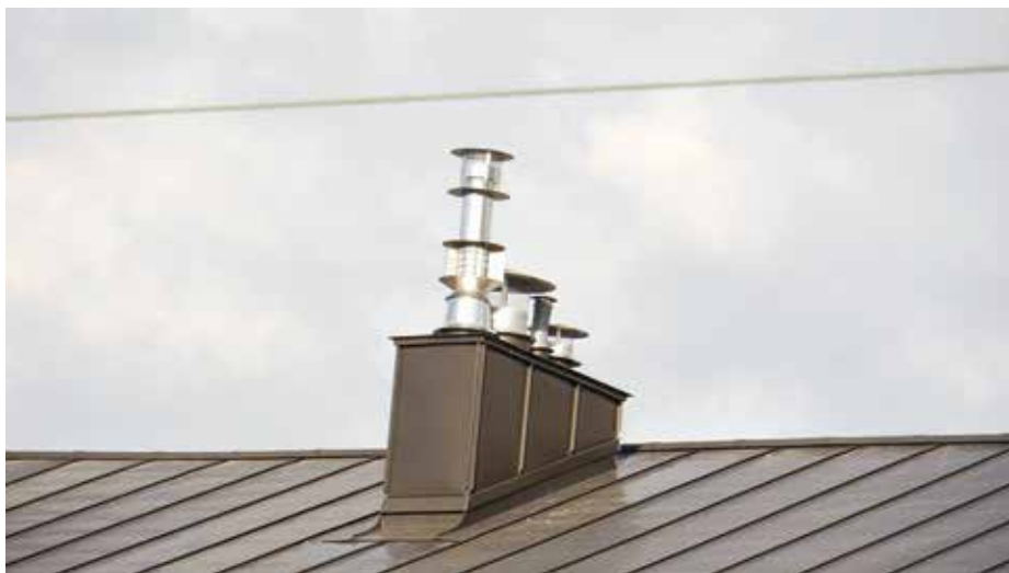
▲ Kominy były bardzo pracochłonnym i czasochłonnym elementem dachu
