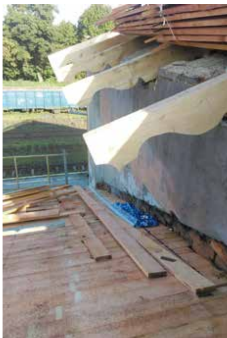
▲ Nowa więźba została bardzo dobrze odwzorowana pod nadzorem konserwatorskim Fot. Arkadiusz Nita
