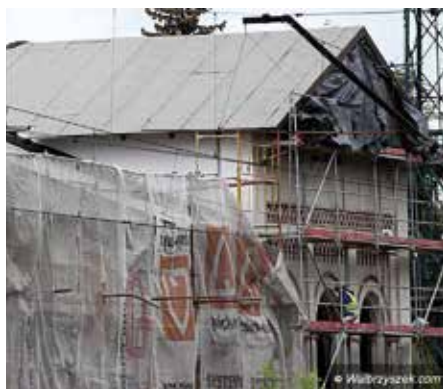
▲ Jeden z dachów został już pokryty papą termozgrzewalną
