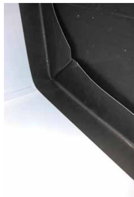
▲ Szczegół obróbki blacharskiej komina
