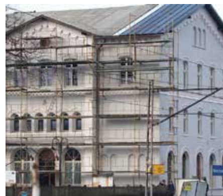
▲ Dach głównego budynku pokryty częściowo papą termozgrzewalną a częściowo już tytan-cynkiem
