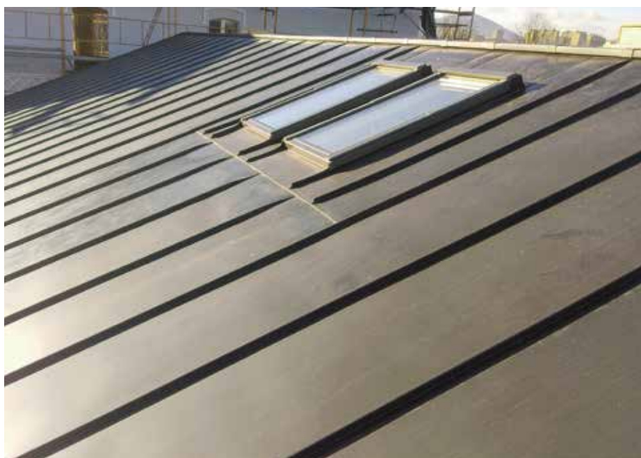
▲ Okna potaciowe po obróbce – idealnie wpisane w linię rąbka
