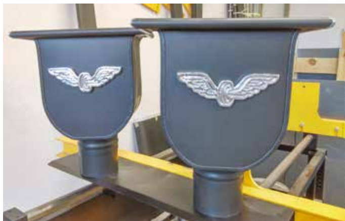
▲ Ozdobne kosze zlewowe wymyślone i wykonane przez firmę dekarzką i użyte na budynku dworca
