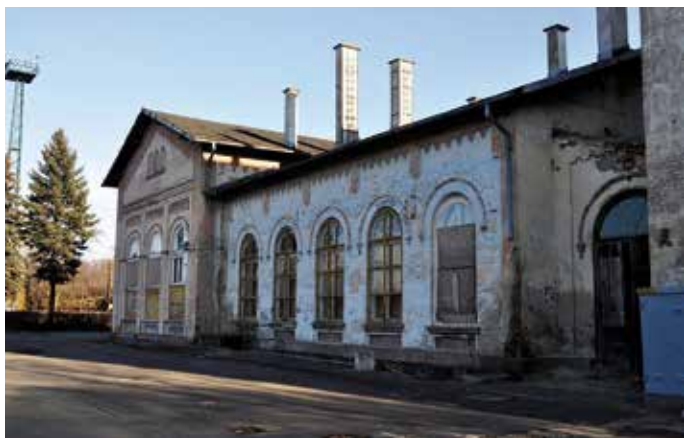
▲ Zabudowania dworca przed remontem – widoczne kominy kottłowni węglowej
